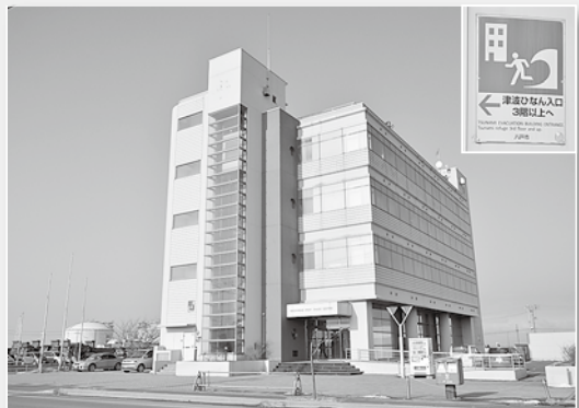
津波避難ビルに指定された八戸港貿易センタービル
