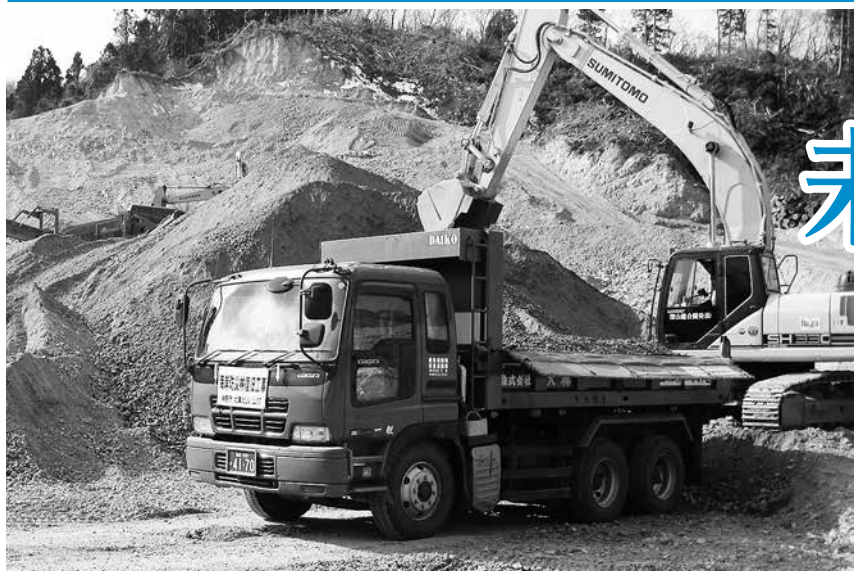
ダンプカーは東北復興の大きな原動力となっている
