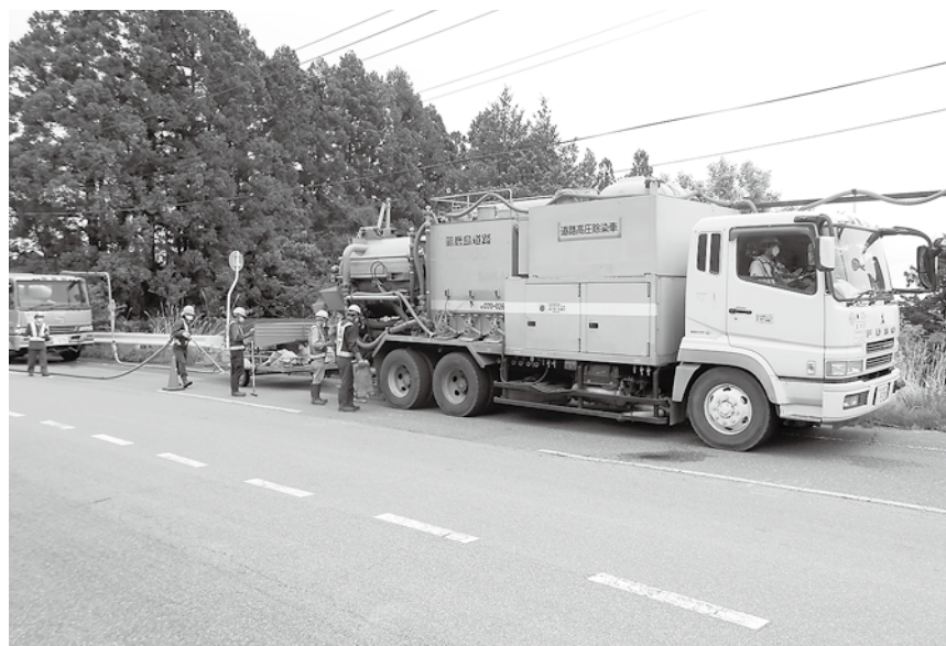
福島県内で道路の除染にあたる「高圧除染車」
