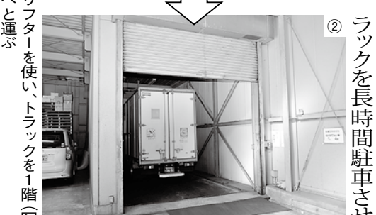
真1階に設置されたトラック用のリフターを使い、トラックを1階写真①から2階(同②)の車庫へと運ぶ
