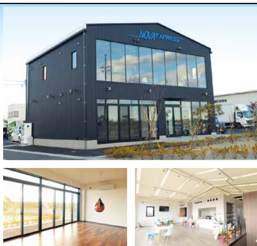
写真上 ノバ・エクスプレス株式会社仙台営業所は、外壁はガルバリウム鋼板、屋根は膜構造(テント構造)によるもの。南に向いた事務所正面は足元から天井までほぼベアガラスで、天井の膜構造と合わせて採光性は非常に高い。前庭は、手洗いなどのイベントスペースとしても使用される予定 写真右 2階事務所は膜構造を活かし天井まで明るく高い空間を確保 写真左 1階入ってすぐ左の多目的室にはアクアサウンドバグ。ストレス解消に役
