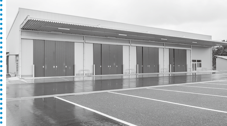
茨城県トラック協会のフォークリフト教習棟と県央総合防災センターはすぐ隣に設置されている
