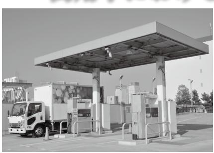
車両が到着すると係員がディスペンサーを操作して充填を開始 (写真園)。小型FCEVトラッ
