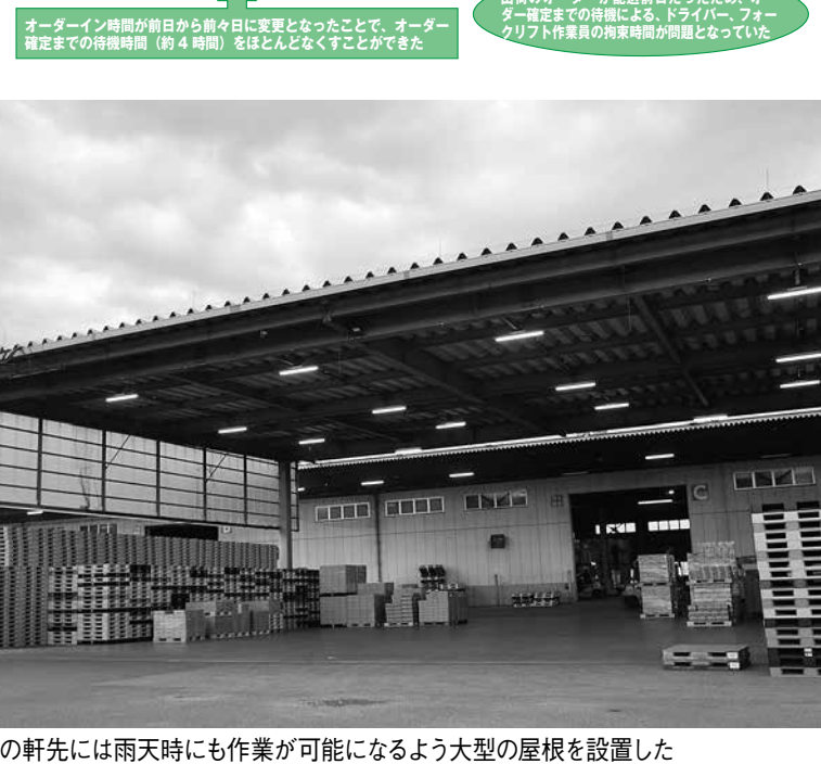
自社倉庫前の軒先には雨天時にも作業が可能になるよう大型の屋根を設置した
