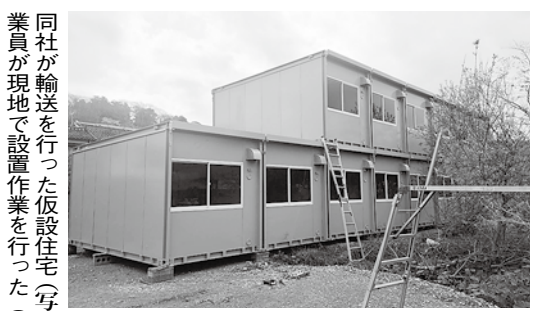
同社が輸送を行った仮設住宅(写真①)。同社は今年2月から3月にかけて10、車100台分ほどの仮設住宅を輸送(写真②)。同社の従業員が現地で設置作業を行った(写真③)
