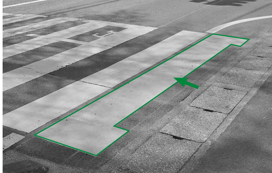
横断歩道の手前に新たに設置された、歩行者待機場所「グリーン・ウェイティング・エリア」(緑枠と矢印は編集部で記入)
