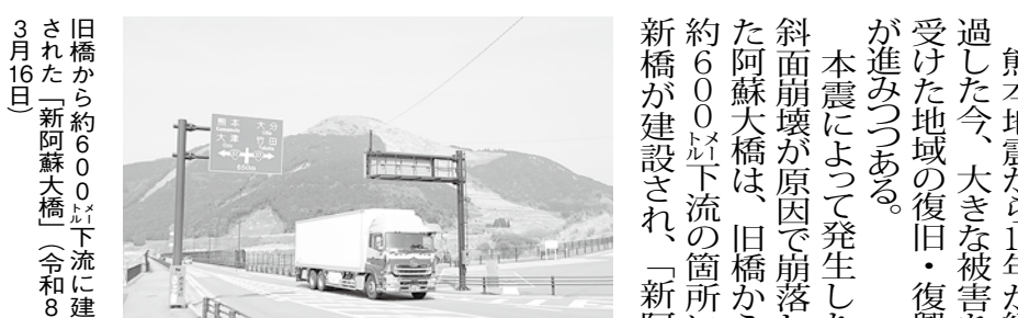
旧橋から約600m下流に建設された「新阿蘇大橋」(令和8年3月16日)
