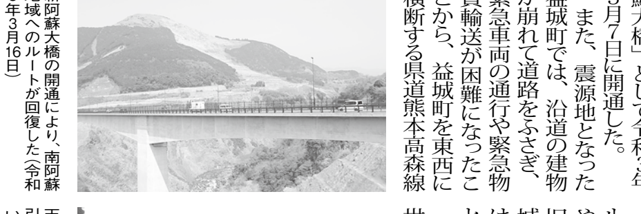
新阿蘇大橋の開通により、南阿蘇地域へのルートが回復した(令和8年3月16日)
