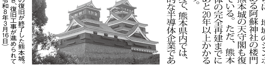
天守閣の復旧が完了した熊本城。引き続き、復旧工事が進められていく(令和8年3月16日)
