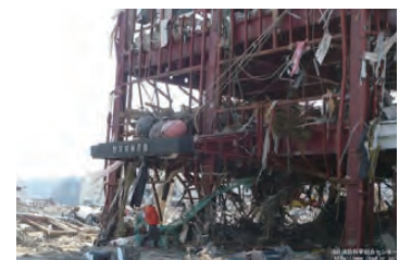
南三陸町役場の被災状況
