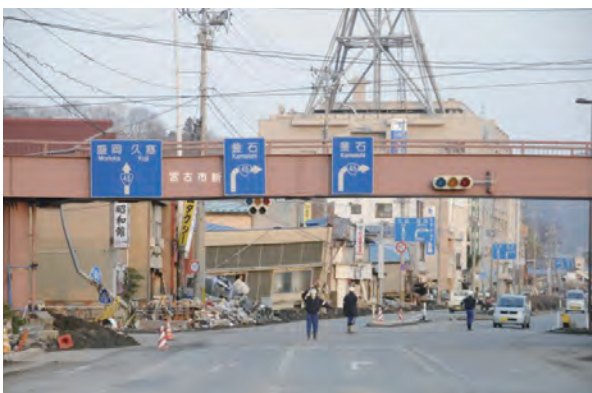
停電で信号が店頭していない交差点（岩手県宮古市）
