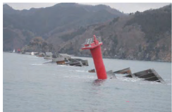
ほぼ全壊した釜石湾港口防波堤（北堤（延長990m））
