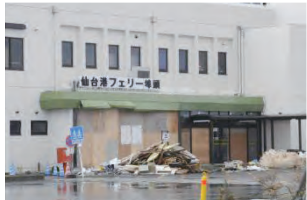
津波で損壊した仙台港フェリーターミナルの施設
