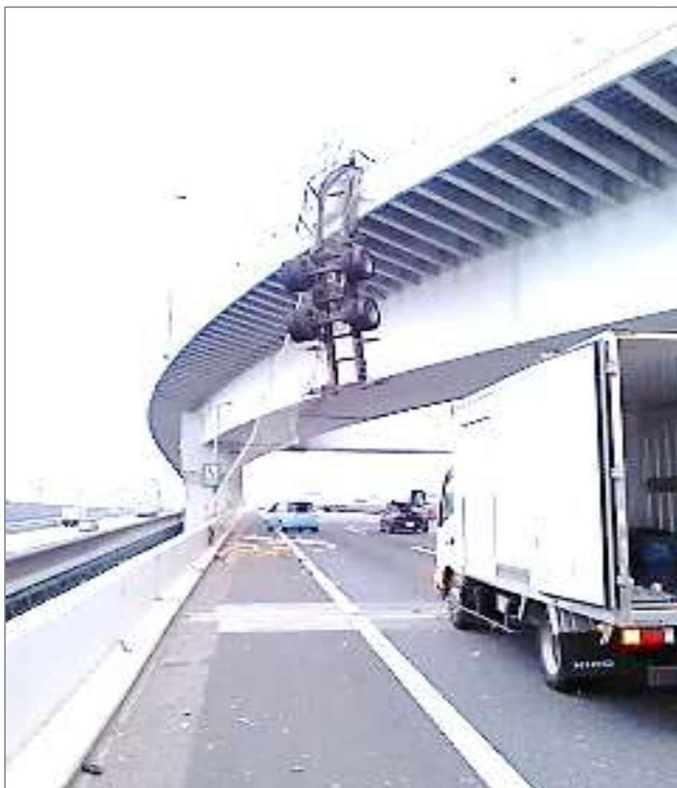
写真5－3 宙づりになったコンテナセミトレーラ (首都高速湾岸線西行きから)
