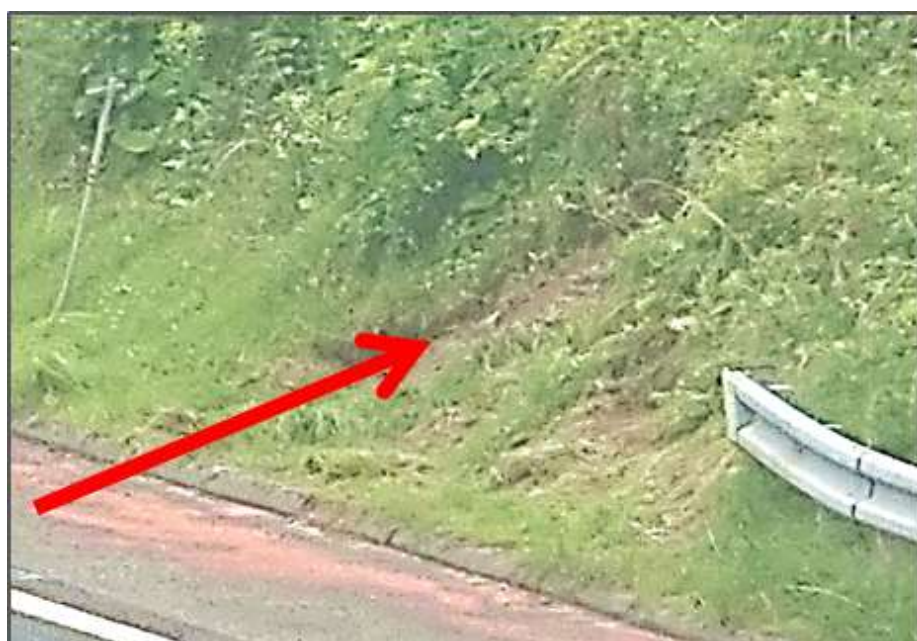
写真5 事故地点（法面乗り上げ地点）
