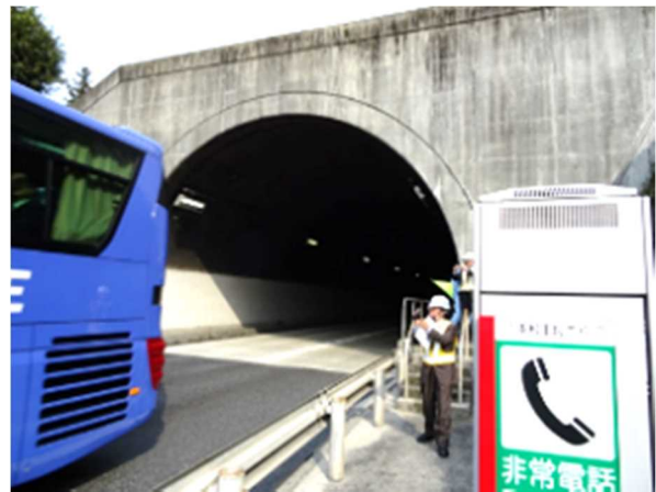
参考写真 26 当該トンネル出口
