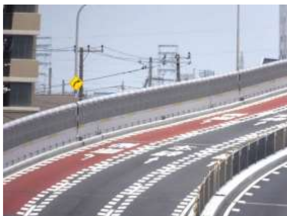
参考写真 3 側道矢印の表示の変更 （↑から↶へ）及び側道のカラー舗装化
