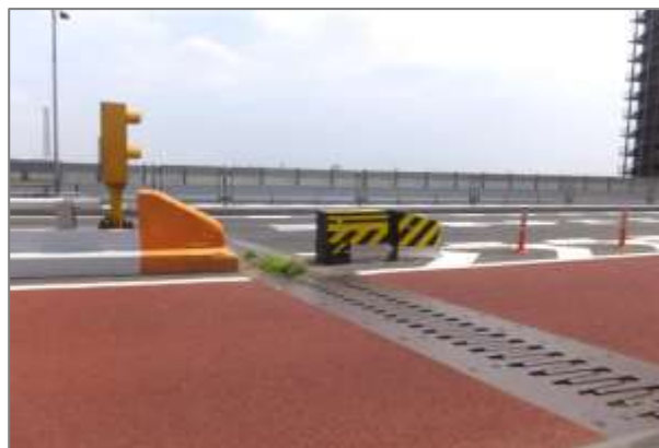
参考写真 2 分離帯の先端部への 緩衝材の設置
