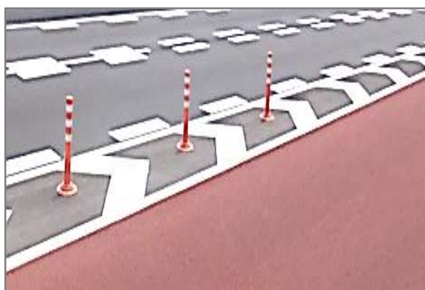
参考写真 4 導流帯への車線分離標の設置
