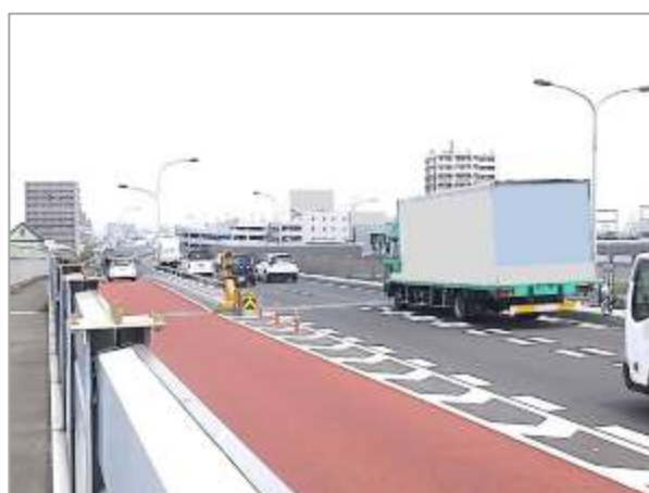
参考写真 5 事故地点手前の状況 （側道のカラー舗装化等）
