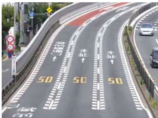
参考写真 1 高架流入部の状況 （側道のカラー舗装化）
