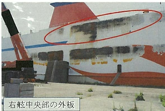
写真2 第3甲板右舷中央部の損傷状況
