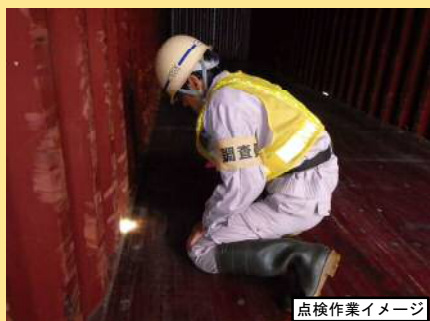
点検作業イメージ
