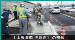
土木構造物(伸縮継手)の補修
