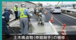
土木構造物(伸縮継手)の補修
