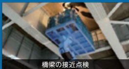
橋梁の接近点検
