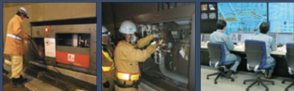
泡消火栓点検
