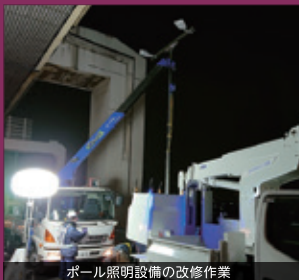
ポール照明設備の改修作業
