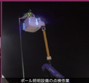
ポール照明設備の点検作業
