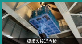
橋梁の接近点検
