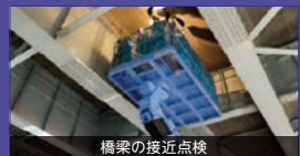
橋梁の接近点検
