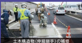
土木構造物(伸縮継手)の補修
