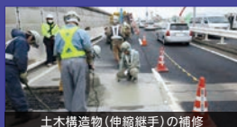
土木構造物(伸縮継手)の補修
