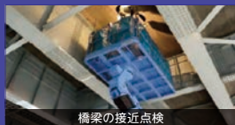
橋梁の接近点検
