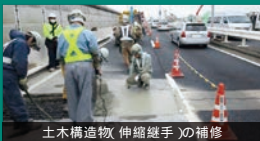
土木構造物(伸縮継手)の補修
