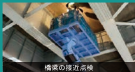
橋梁の接近点検
