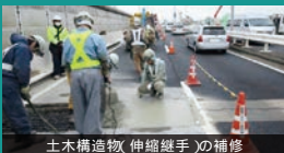
土木構造物(伸縮継手)の補修
