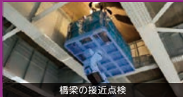
橋梁の接近点検
