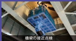
橋梁の接近点検
