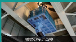
橋梁の接近点検
