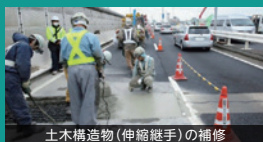
土木構造物(伸縮継手)の補修
