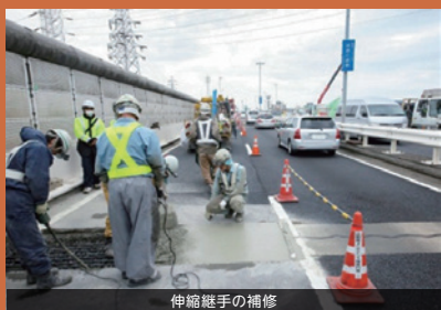
伸縮継手の補修
