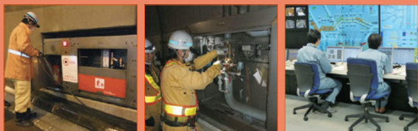
泡消火栓点検
