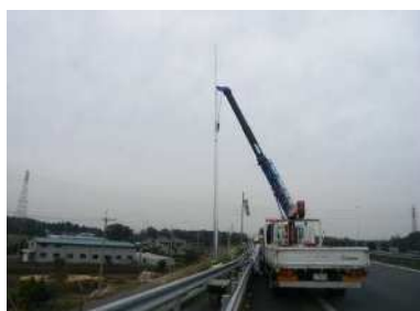
道路照明設備工事
