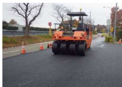
舗装補修工事
