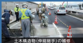
土木構造物(伸縮継手)の補修
