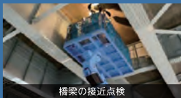
橋梁の接近点検
