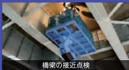
橋梁の接近点検
