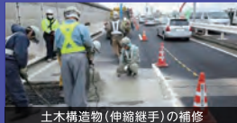
土木構造物(伸縮継手)の補修
