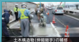
土木構造物(伸縮継手)の補修
