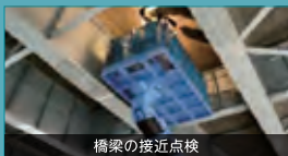
橋梁の接近点検
