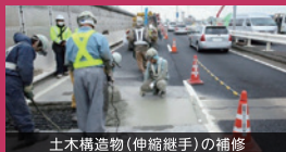
土木構造物(伸縮継手)の補修
