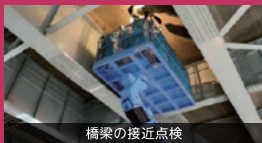
橋梁の接近点検
