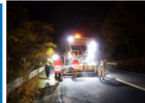
(舗装修繕工事)
