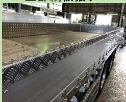
上部縞板張り
