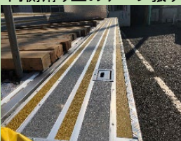
内側滑り止めテープ張り
