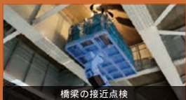
橋梁の接近点検
