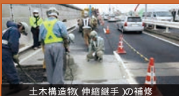
土木構造物(伸縮継手)の補修
