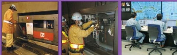
泡消火栓点検
