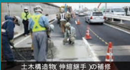
土木構造物(伸縮継手)の補修
