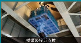
橋梁の接近点検
