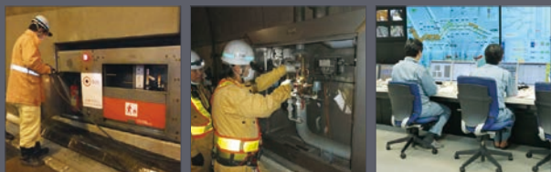
泡消火栓点検
