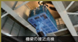
橋梁の接近点検
