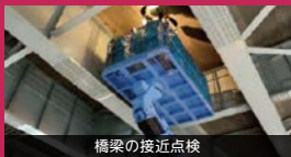
橋梁の接近点検
