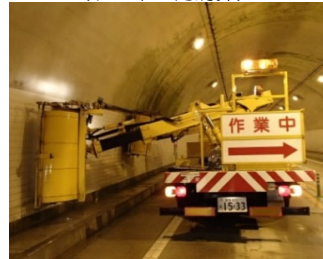
(トンネル内清掃)
