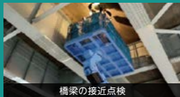
橋梁の接近点検
