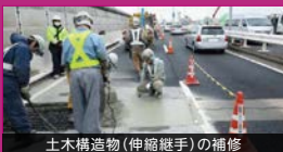
土木構造物(伸縮継手)の補修
