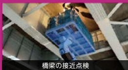
橋梁の接近点検
