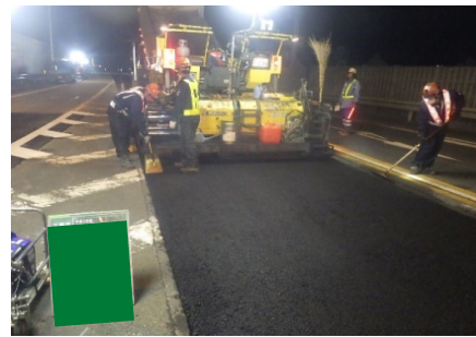
（舗装修繕工事）
