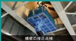
橋梁の接近点検
