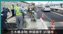
土木構造物(伸縮継手)の補修
