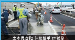
土木構造物(伸縮継手)の補修
