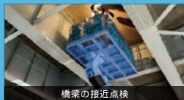
橋梁の接近点検
