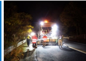
(舗装修繕工事)
