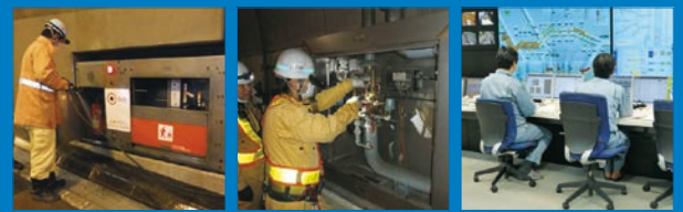
泡消火栓点検 水噴霧装置点検 施設管制室
