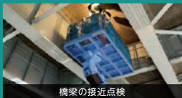
橋梁の接近点検
