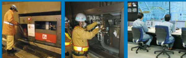
泡消火栓点検
